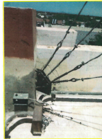
Reforzamiento retenidas, tensores
