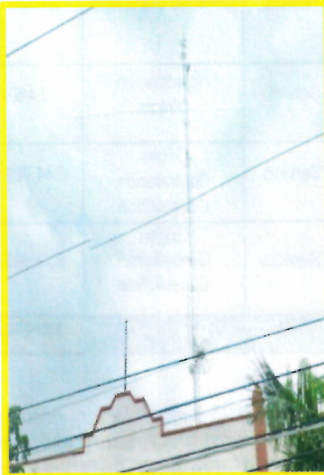
Torre Unison Navojoa (sin estabilizadores)
